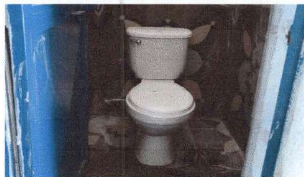
Foto 2: Sustitucion de inodoros en modulos 1 y 2.
