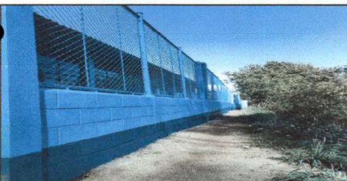
Foto 5: Reparación de tubo hg y malla galvanizada en el centro educativo.
