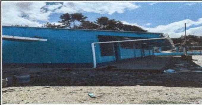
Foto1: Sustitución por lamina troquelada aluzinc calibre 26 en modulo 1.
